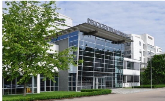
Das Druckzentrum Passau wurde Anfang der 90er Jahre erbaut.
